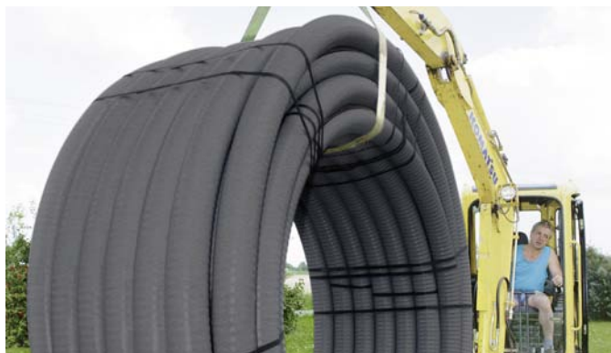
Sl. 47 Podizanje bagerom
