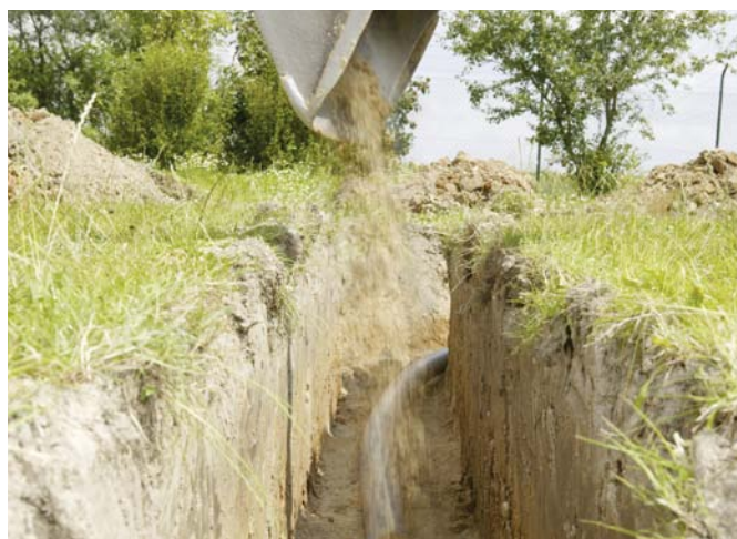
Sl. 56 Nasipavanje rova za cevi peskom
