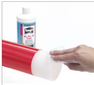
Abb. 95 Abschabereich muss staub- und fettfrei sein. Mit ausreichend Tangit-Reiniger säubern und komplett verdunsten lassen.
