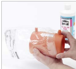
Abb. 96 FUSAPEX-Elektroschweißmuffe erst jetzt dem Beutel entnehmen. Wenn erforderlich Schweißmuffe mit Tangit säubern.
