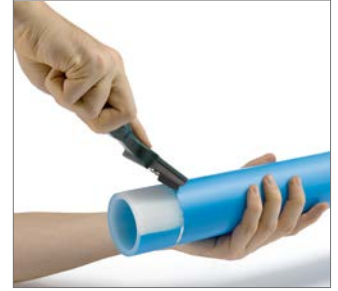
Abb. 41 3. Beschichtung mit Handschaber vollständig entfernen. Nicht über die Markierung hinwegschaben. Der Span sollte eine Dicke von ca. 0,2 mm haben.
