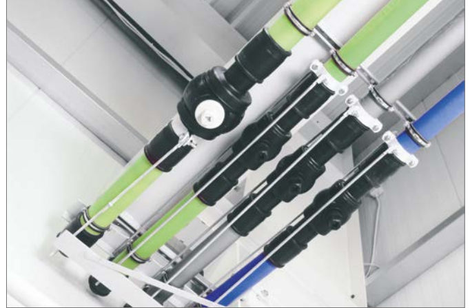
Abb. 140 Zugvorrichtung und Festpunktstruktur im Objekt Winkelmann GmbH + Co. KG
