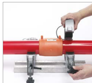
Abb. 106 Nach der am Fitting angegebenen Abkühlzeit „Cool: ... min“ darf die Universalrohrhalteklemme demontiert werden.
