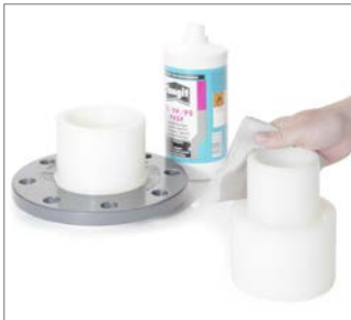
Abb. 117 Flansch und Reduzierung werden nicht geschält, sondern vor dem Verschweißen nur gereinigt.
