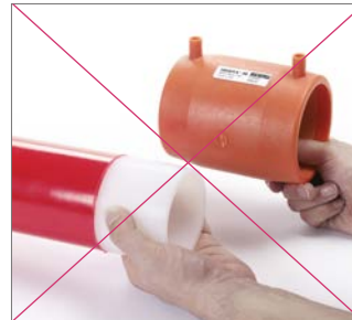
Abb. 119 Schweißzonen nicht berühren. Notfalls verunreinigte Schweißzonen immer mit Tangit vor dem Verschweißen reinigen.
