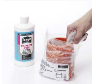
Abb. 114 Die Elektroschweißmuffe FUSAPEX erst kurz vor der Verarbeitung dem Beutel entnehmen, wenn erforderlich reinigen.
