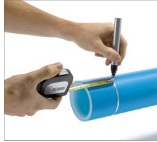
Abb. 40 2. Das Abschabmaß gemäß Tabelle 8 anzeichnen.
