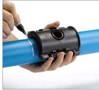
Abb. 53 1. Anbohrschellenunterteil an gewünschter Position anlegen und anzeichnen.
