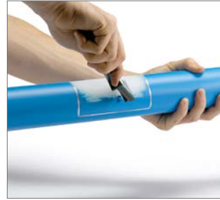
Abb. 54 2. Zwischen den beiden Markierungen Ummantelung auf halbem Umfang des Basisrohres mit Handschaber entfernen. Der Span sollte eine Dicke von ca. 0,2 mm haben.
