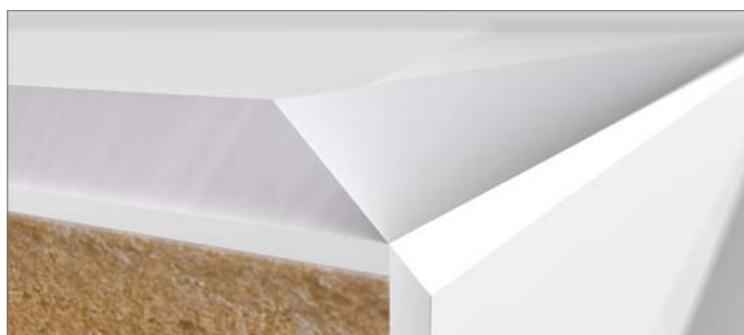
Fig. 11-20 Biselado 45° sobre orla e superfície
