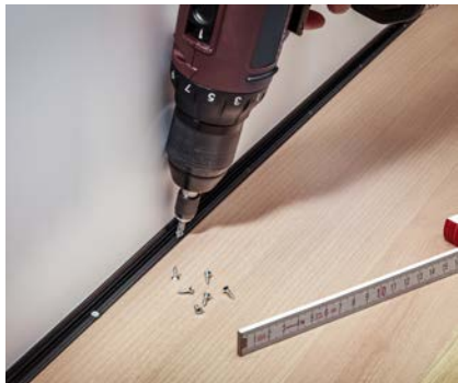
4. Прикрутіть (шуруп для ДСП з потайною головкою 2,5 x 10) – опціонально
